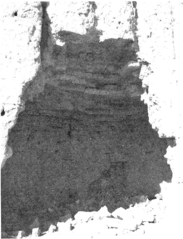
شکل ۱۵: قوس ناپایدار که با خشتهای افقی اجرا شده است
