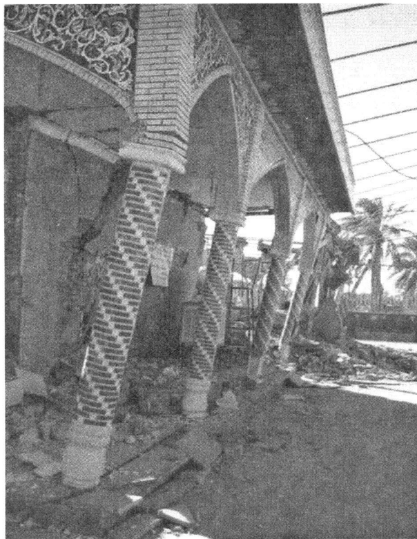
شکل ۵: تغییر شکل چشمگیر حاصله بر اثر زمین لرزه در بنایی با ستونهای فلزی پوشیده از تزئینات کاشی
