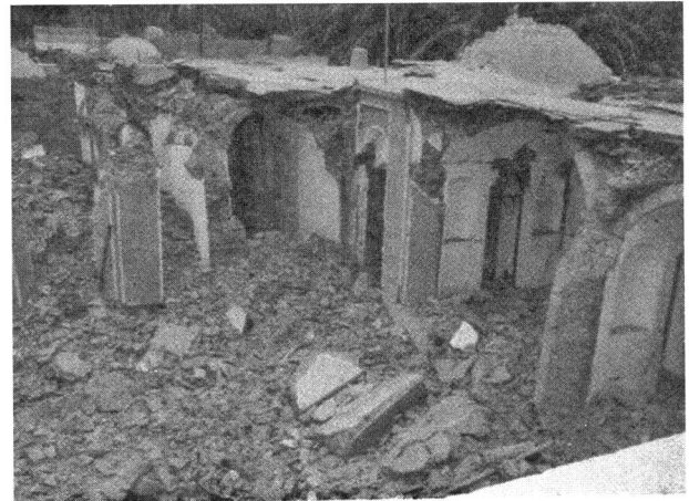
شکل ۴، ۳: برخی از بناهای خشتی فروریخته در شهر بم بر اثر زمین لرزه
