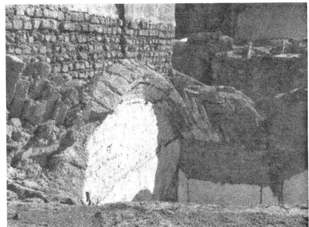
شکل ۱۶: طاق ضربی اجرا شده با خشتهائی که به صورت مایل از روی اسپر برخاسته که امکان ساخت آن را بدون استفاده از قالب میسر ساخته است.
