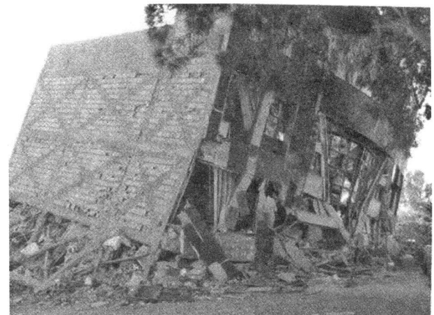
شکل ۶: فروریختگی بنایی با اسکلت فلزی که فاقد بادبندهای مناسب در طبقه هم کف است
