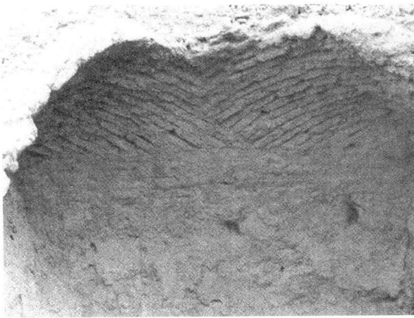
ش ۱۸- نحوه خشت چینی در یک طاق کلمبو که بدون استفاده از قالب اجرا شده است
